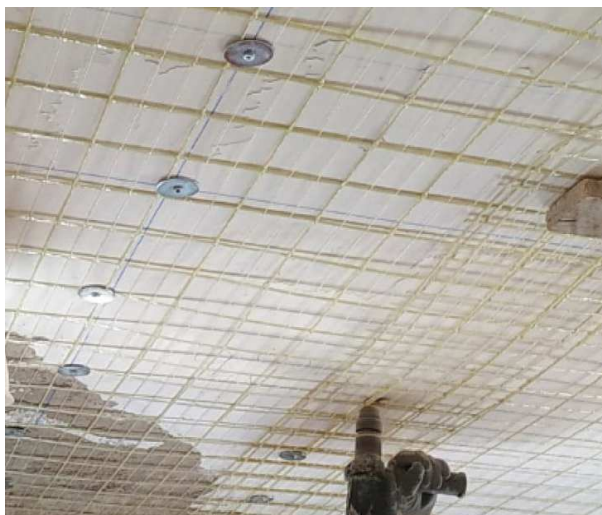
Immagine a titolo esemplificativo della rete antisfondellamento a vista
